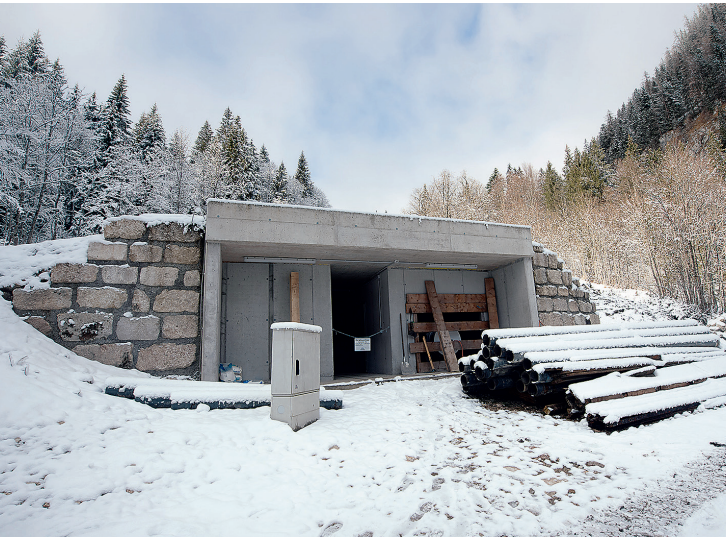
Abb. 3: Trocknergebäude für einziehende Wetter vor dem Kaiser-Josef-Stollen
